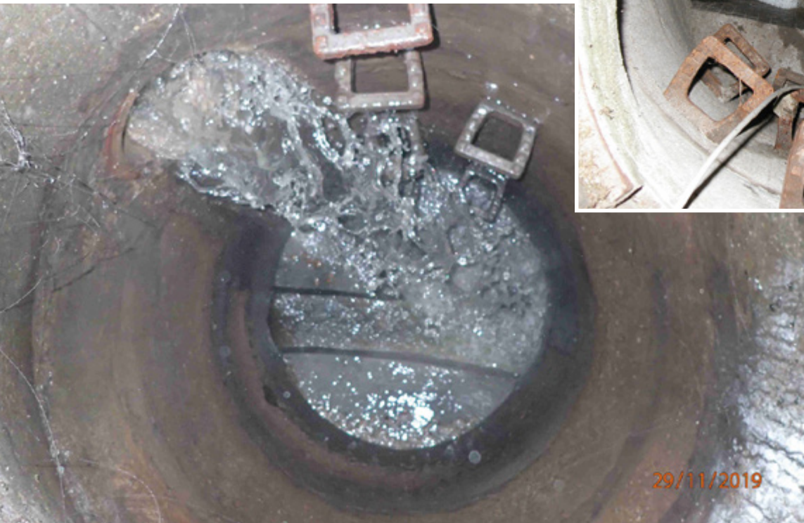
Sanierungsbedürftige Kanalhaltung mit Fremdwasserproblem
