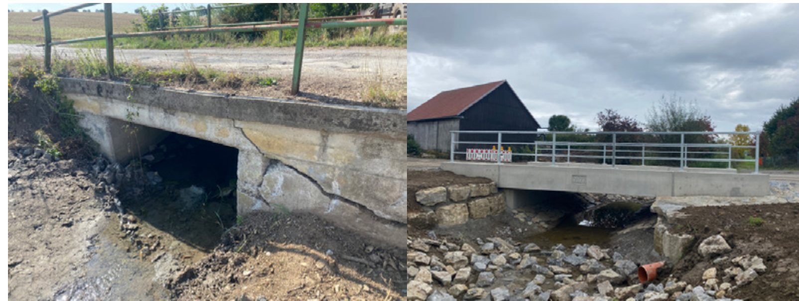
Instandgesetzte Brücke (links vorher, rechts nachher)
